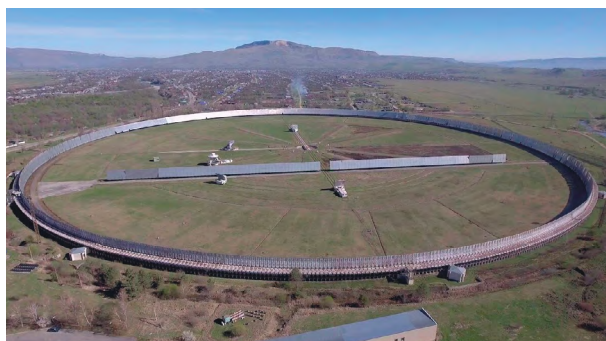
Советский радиотелескоп РАТАН-600. Его диаметр (576 м) остается самым большим в мире по сей день
